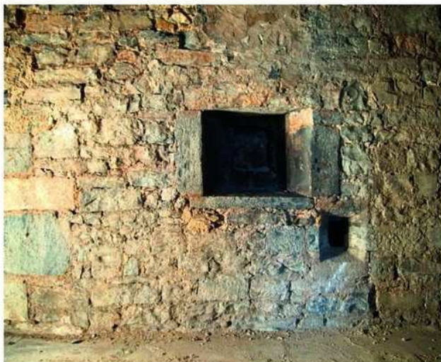
Fig. 6 Ouverture intérieure de visée et canonnière
