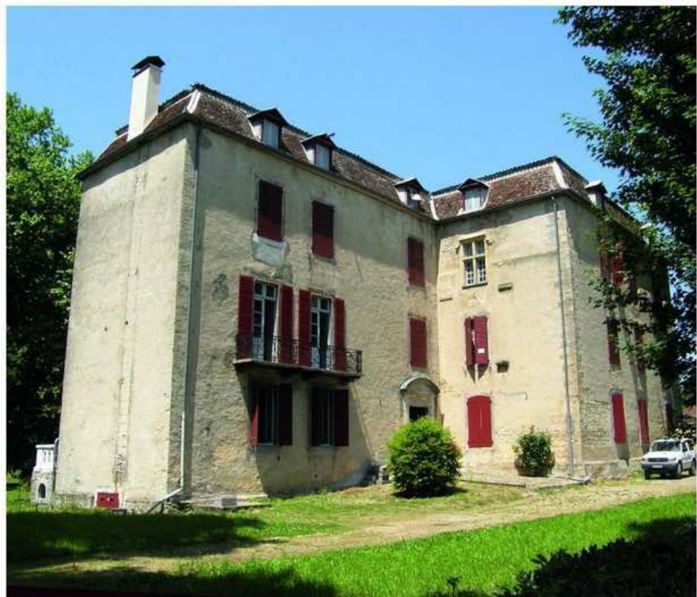
Fig. 1 Le château d'Uhart- Mixe : façade est (parties centrale et méridionale)
